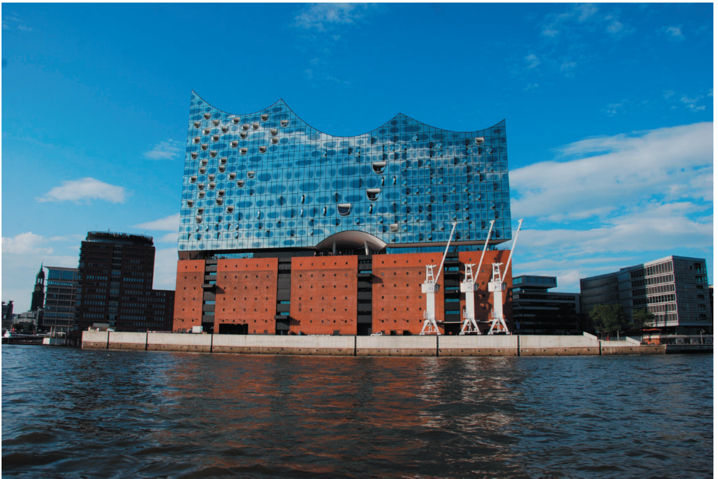
Figura 6: Amburgo, Hafen City, la Elbphilharmonie di Herzog & de Meuron vista dall'Elba. Si notino le finestre per abitazioni.
